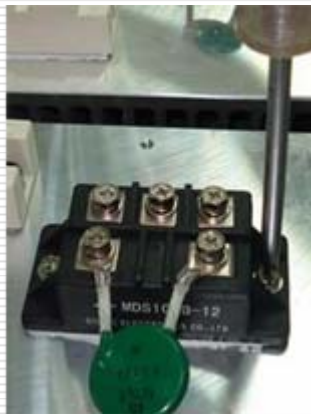
2 用十字形起子将整流桥的固定螺丝拆下
