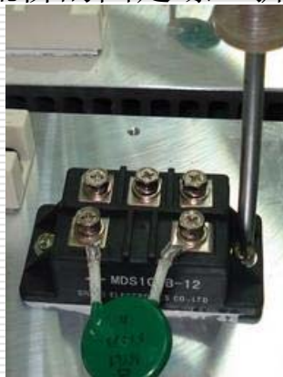
5 用十字形起子将整流桥紧固在散热器上
